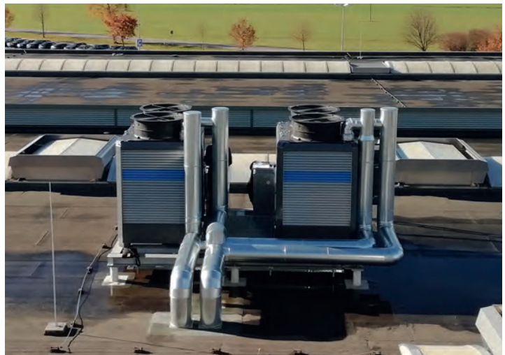
Die Energieeffizienzlösung efficiency Pack eP 05.15 lässt sich auf dem Dach installieren. Das einzelne Pack hat dabei ungefähr die Größe einer Duschkabine.
