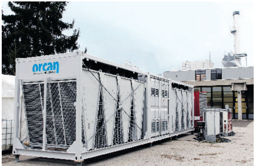
Der „efficiency Pack eP 150.200“ der Orcan Energy AG mit einer elektrischen Leistung bis 200 kW(el.) an der Versuchswärmequelle der Technischen Universität München in Garching. Bild: Orcan Energy
